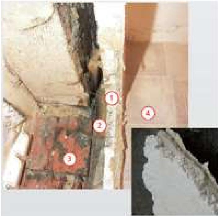
**Abb1**Wandaufbau in der Untersicht des Fenstersturzes: 1Styropor-Verbundplatte aus 1,25 cm Gipsfaser und 1,5 cm Styropor auf 2Holzleisten, Luftzwischenraum, 3Hochlochziegel, 4innen folienbespannte Fliesentapete (DFWZ QLB)
